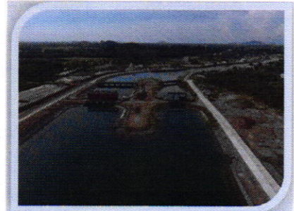
งานชุดคลองผันน้ำ สถานีสูบน้ำ และประตูระบายน้ำ พร้อมอาคารประกอบ สัญญาที่ 1
